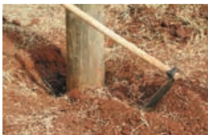
9 ► Cubra parte do buraco com terra. Não coloque capim ou galhos, pois podem comprometer a compactação.
