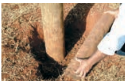
12 ► O travesseiro é uma madeira de boa qualidade com, no mínimo, 10 cm de bitola e 80 cm de comprimento. Ele deve entrar justo entre a terra e o mourão.
