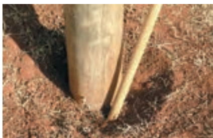
10 ► Use o socador para compactar a terra. Repita a operação em camadas. Essa etapa é importante para o mourão não se deslocar.
