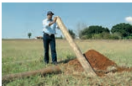
6 ► Coloque o mourão dentro do buraco.
