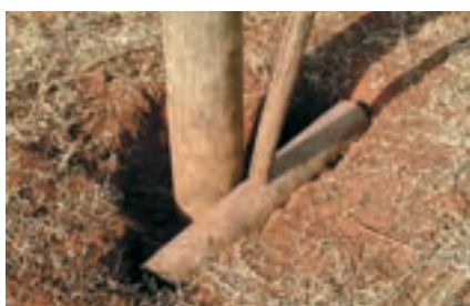
13 ► Soque o travesseiro. Ele deve ficar 10 cm abaixo do nível do solo.
