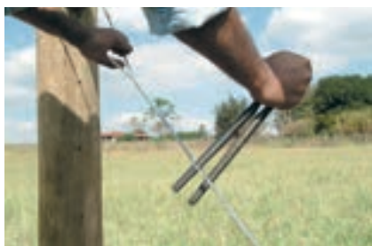
49 ▶ Comece o movimento de torção dos rabichos. Tenha cuidado para a ferramenta não escapar. Quando os rabichos estiverem bem torcidos, volte um pouco a torquês e retire-a.
