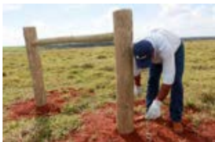
43 ▶ Passe o rabicho na barra de ancoragem.
