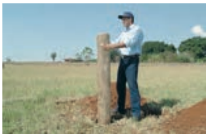
7 ► Ajuste a altura do mourão. A altura padrão de cerca no Brasil é 1,50 m, mas ela pode variar de 1,40 m a 1,60 m, dependendo da região.
