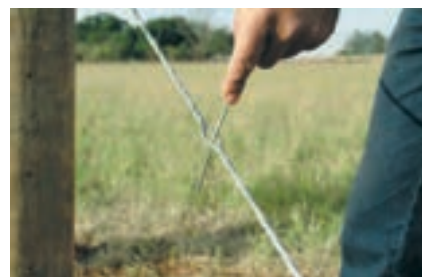
50 ▶ Depois de retirar a torquês, ficou um espaço (olhal). Utilize 1 m de arame (ovalado ou galvanizado BWG 8) para fazer o arremate.
