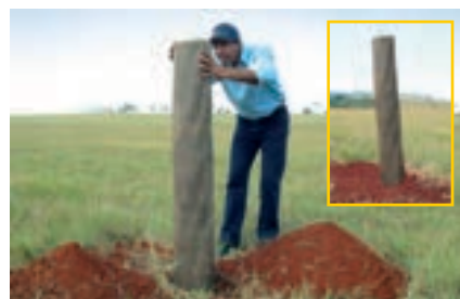
8 ► Alinhe o mourão com o final da cerca. Depois, incline-o um pouco para trás (veja detalhe na foto). Ele ficará reto após os arames ser esticados.
