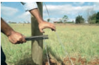
48 ▶ Observe que os rabichos estão paralelos. Inicie sua torção utilizando o cabo da torquês. Evite usar madeira neste processo. Ela pode quebrar e causar acidentes.
