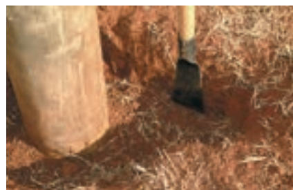
11 ► Abra uma vala bem justa na frente do mourão para receber o travesseiro (veja ilustração no item 17).
