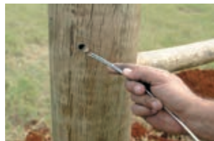
44 ▶ Passe os rabichos nos furos, um de cada lado, de maneira a sair na outra extremidade. Esse furo foi feito no passo 19.
