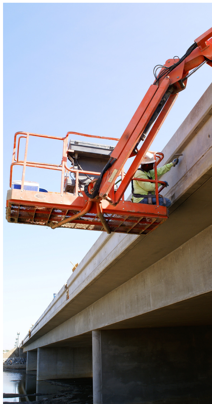
Figura 1.14 Ponte de concreto armado sendo inspecionada
